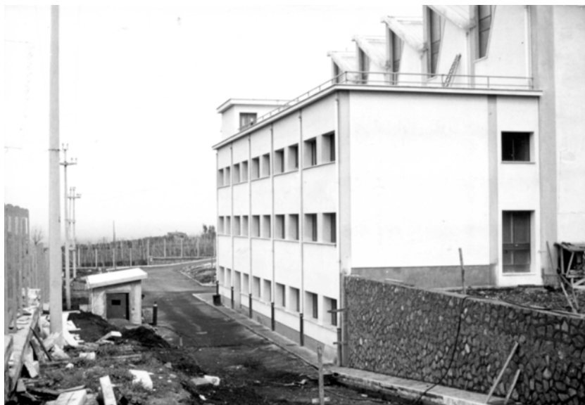
Figura 10.9: Esterno della soffieria di vetro del Laboratorio Gas Ionizzati di Frascati. Sulla sinistra è visibile la centralina con le bombole di idrogeno e ossigeno.
